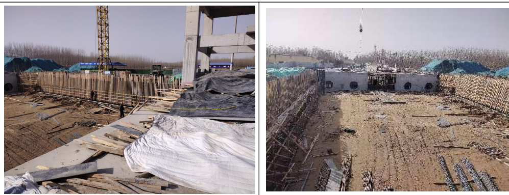
图 7-1 施工期防尘布、防尘网及四周设置围挡照片
