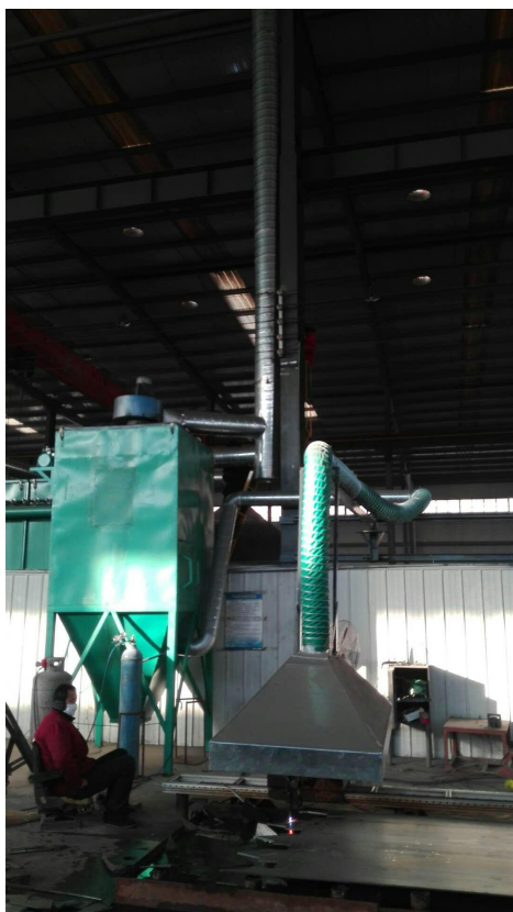
焊接气割工序排气筒（1#）
