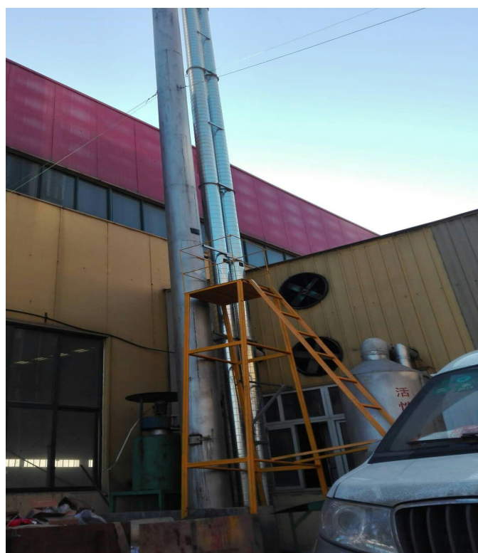
喷塑、天然气燃烧和喷涂工序排气筒（3#、4#和5#）
