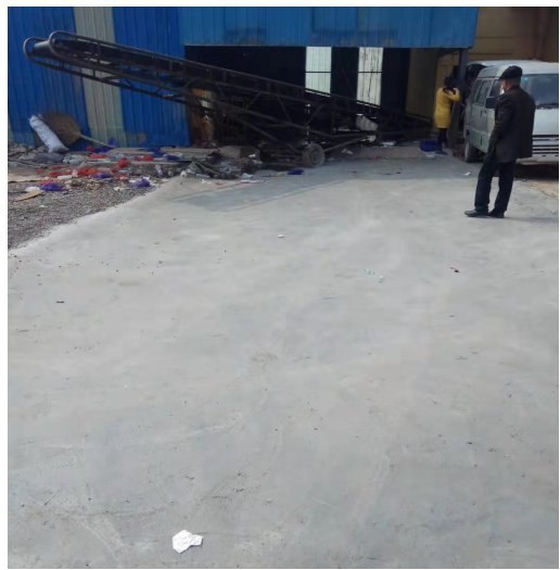
厂区外地面硬化
